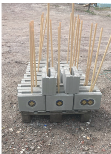
voorbereiding wandcontactdozen
